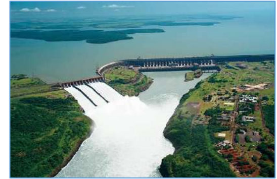
ГЭС Итайпу Бразилия / Парагвай 14000 МВт (1984 г.)
