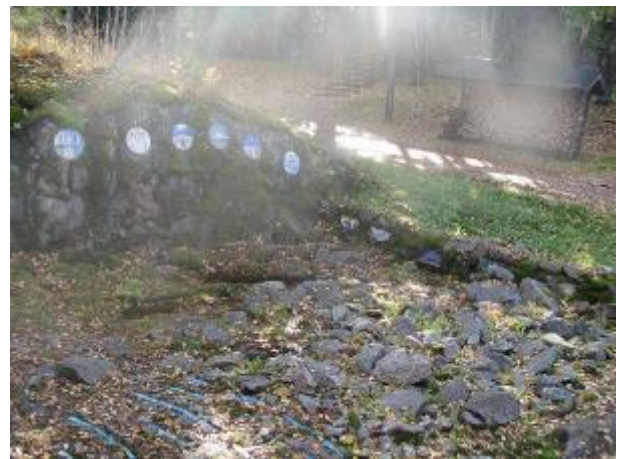
8. Часовня в Йорвасе. Вид на угол южной и западной стены
